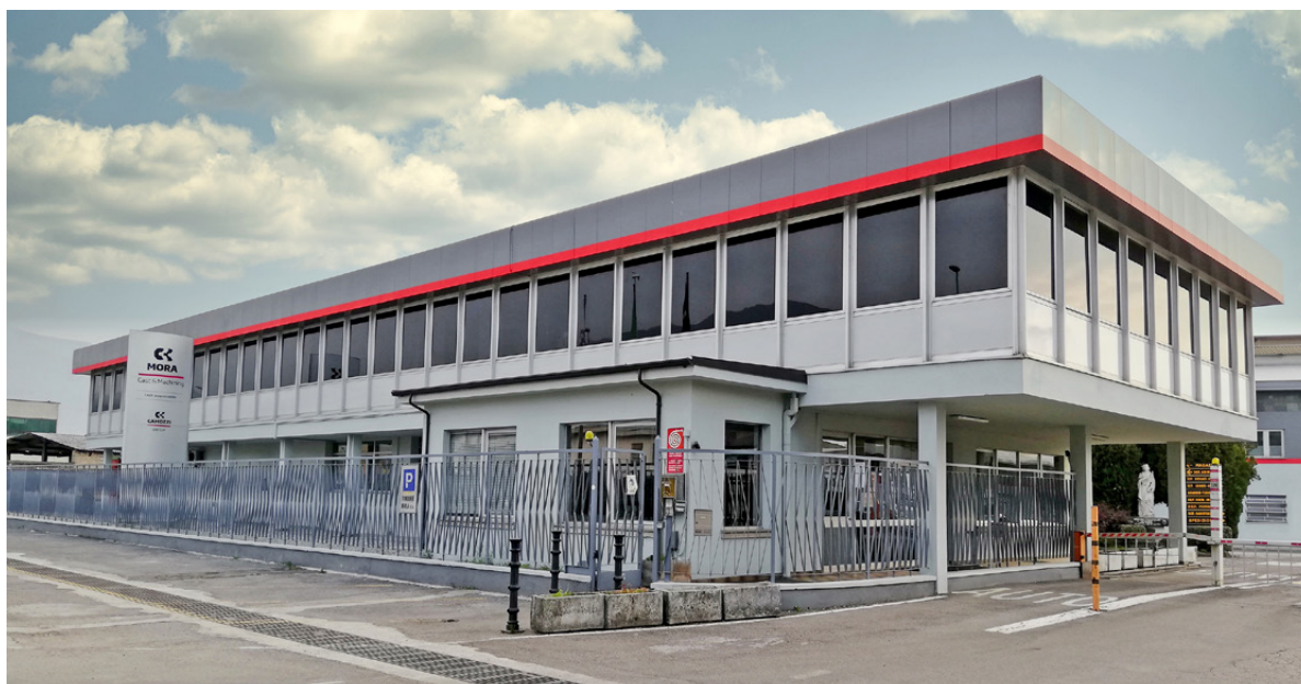
La sede di Fonderie Mora Gavardo a Gavardo, presso Brescia
